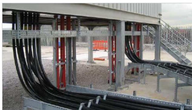
для монтажа энергоблоков и кабельных каналов
