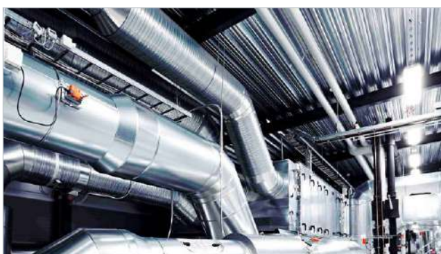
для монтажа трубопроводов
